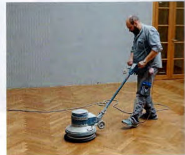
Anschließend wird die Bodenfläche mit der Maschine auspoliert.
