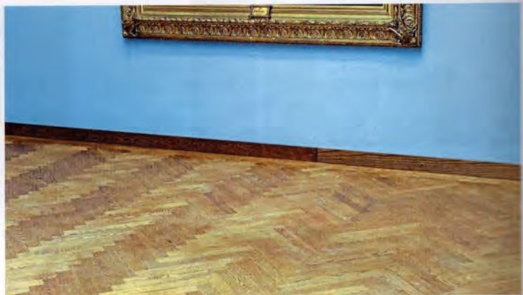
Der fertig aufbereitete historische Parkettboden in der Sammlung Schack.
